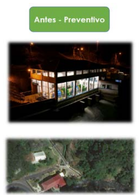
Figura 8. Acciones de rehabilitación y mejora a la infraestructura de ESPH
