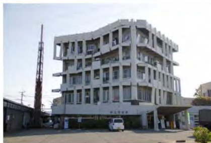
被災した宇土市役所
