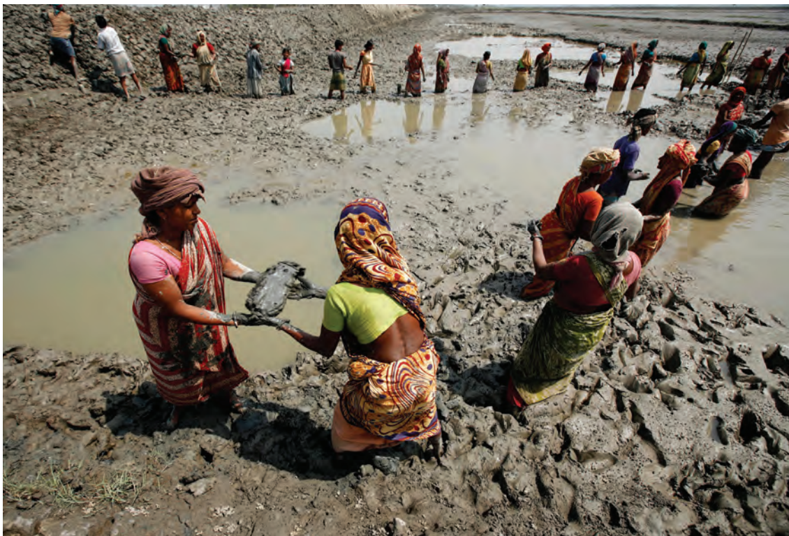
Mujeres trabajan para reconstruir un terraplén en una de las regiones afectadas por el ciclón Aila en Dacope, Khulna, Bangladesh.
